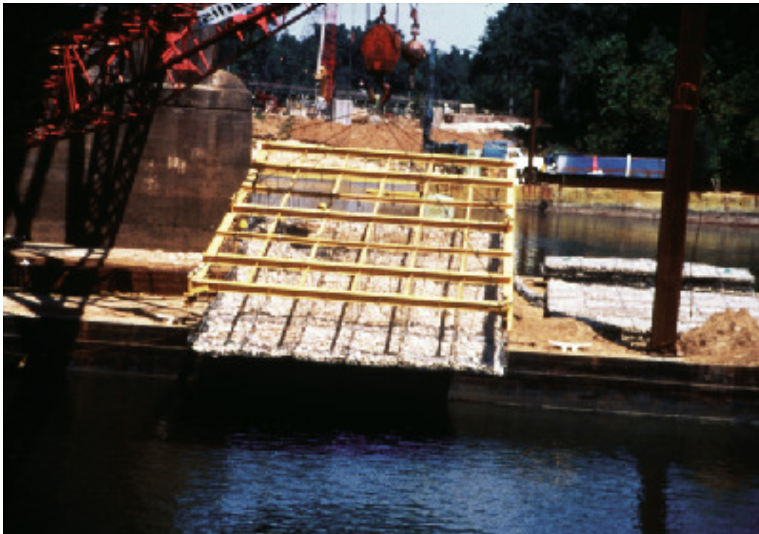
Protección Subacnea para Pilar, Departamento de Transporte, USA
