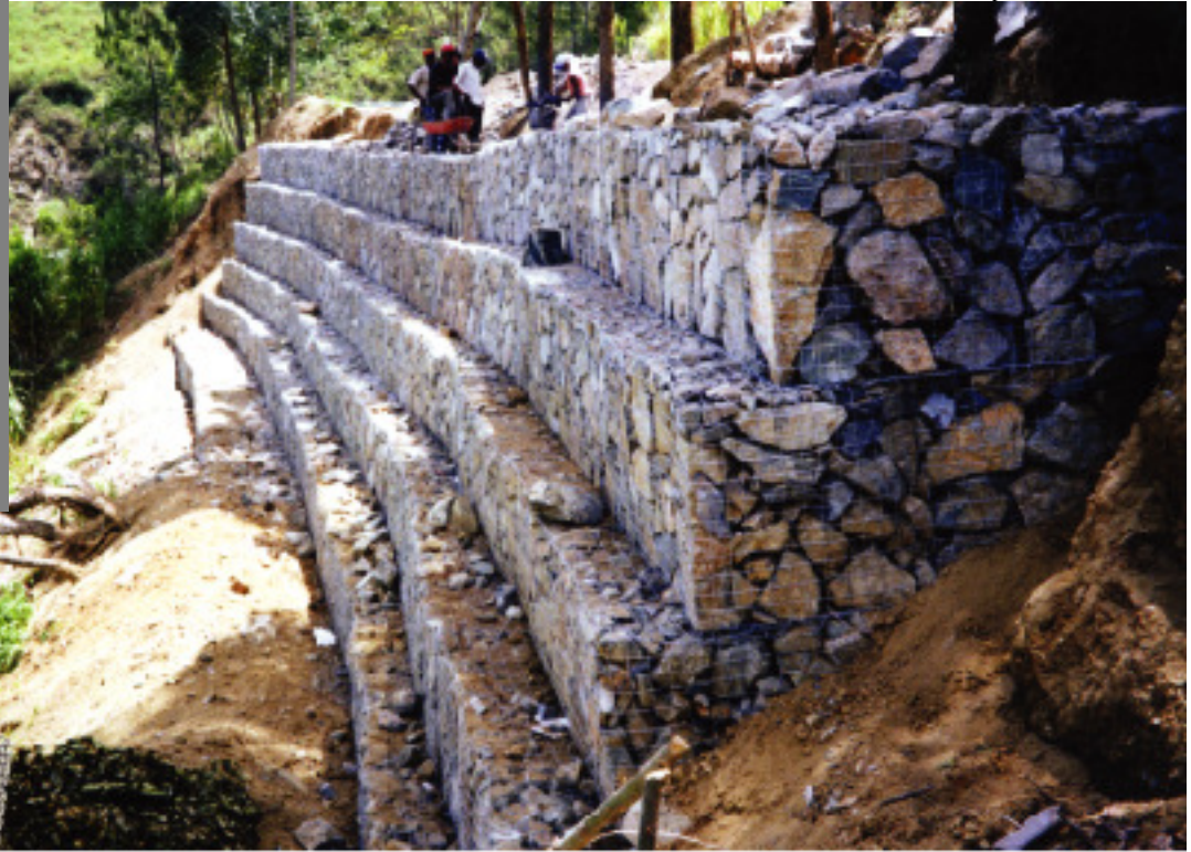
Muro de contención, República Dominicana
