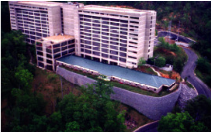
Muro en gaviones con el sistema de tierra armada, USA
