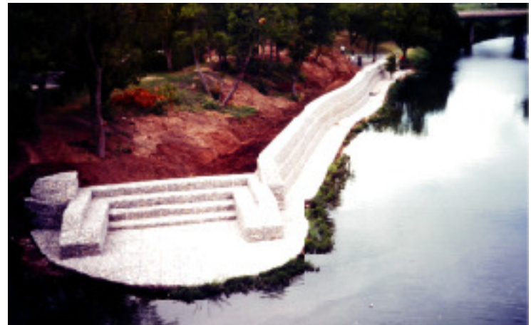
Control de material de arrastre, USA
