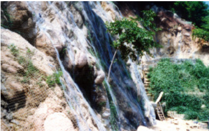
Protección contra el desprendimiento de rocas, México
